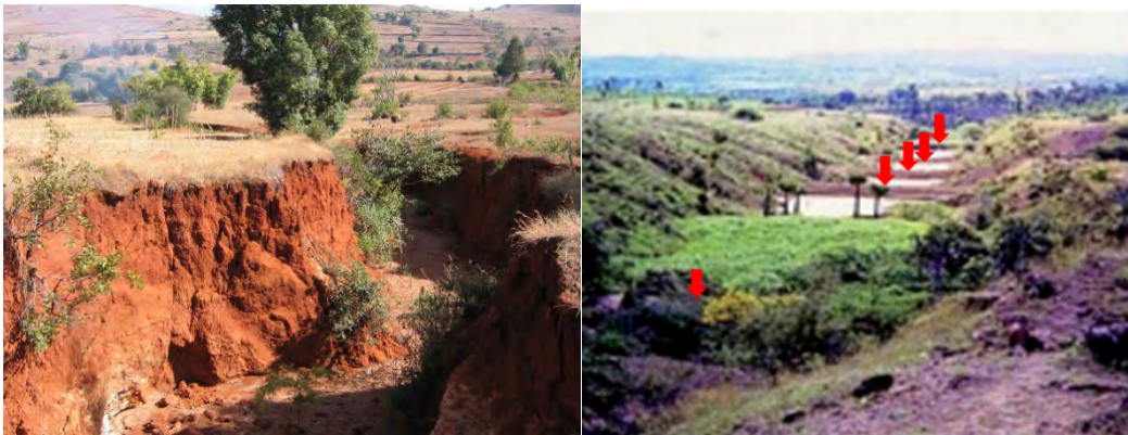
図 3-2-2 ミャンマーにおけるガリー侵食とチェックダムによる侵食の防止(左: シャン州で見られるガリー. 右: 中央乾燥地での UNDP/FAO によるガリー侵食対策としてのチェックダムを赤色矢印で示した)
